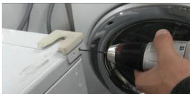
5. Fixe os dois lados do suporte traseiro do kit junção com parafusos no topo da lavadora.
