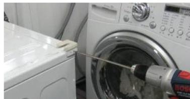
6. Coloque a secadora em cima da lavadora e encaixe os pés niveladores da secadora no suporte traseiro de instalação, conforme indicado na foto abaixo. Para evitar ferimento, tenha cuidado para não prender os dedos entre a lavadora e a secadora. Deslize a secadora para trás até o final do suporte traseiro.
